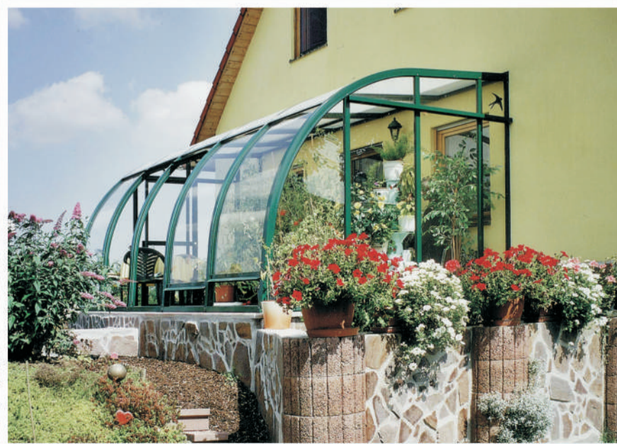
Sonneneranda Berlin maßgenau auf erhöhter Terrasse
