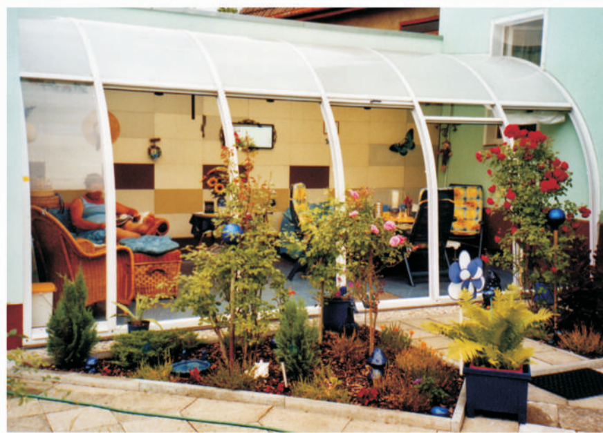
Sonneneranda Berlin mit Paßfeld* zwischen 2 Gebäude montiert
