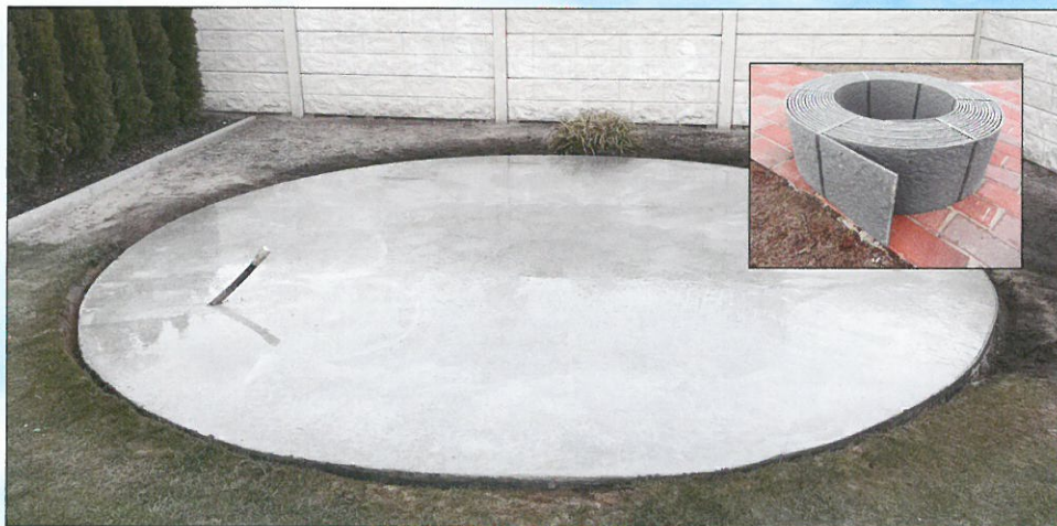
Flexible Einfassung als Schalungsring zur Erstellung einer Bodenplatte für den Pavillon aus recyceltem Kunststoff, biegsam und verrottungsfest. Einfache Handhabung.
